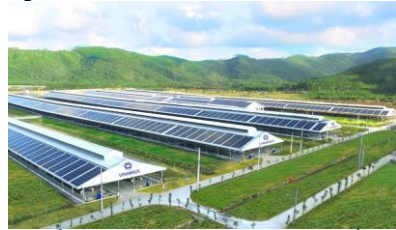
Hệ thống năng lượng mặt trời được lắp đặt tại các trang trại của Vinamilk.
